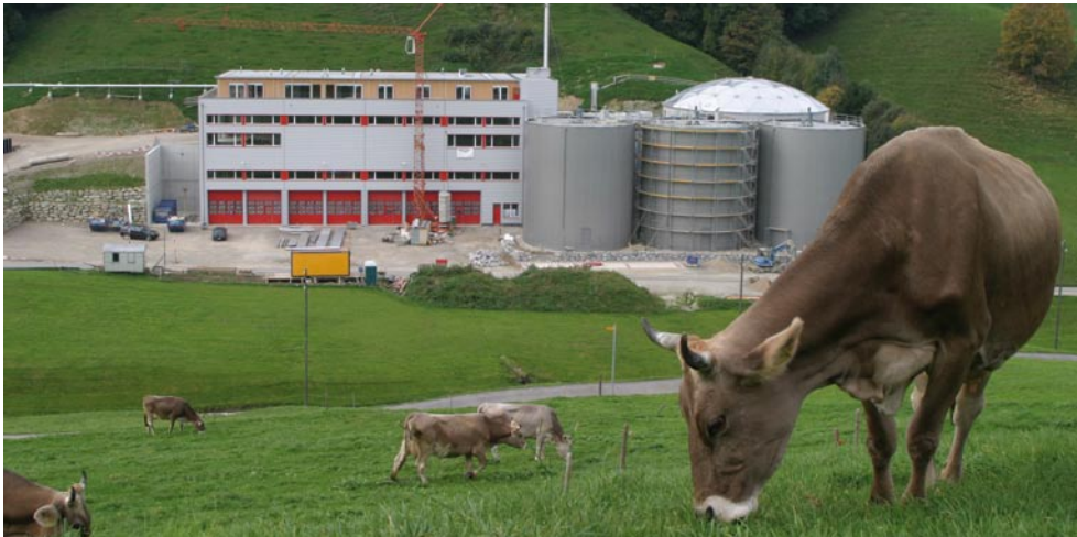
Die Schweizer Jakob Bösch AG nutzt das aus verschiedensten Organika gewonnene Biogas zur Gewinnung von Strom und Wärme mit einem Blockheizkraftwerk (BHKW).
