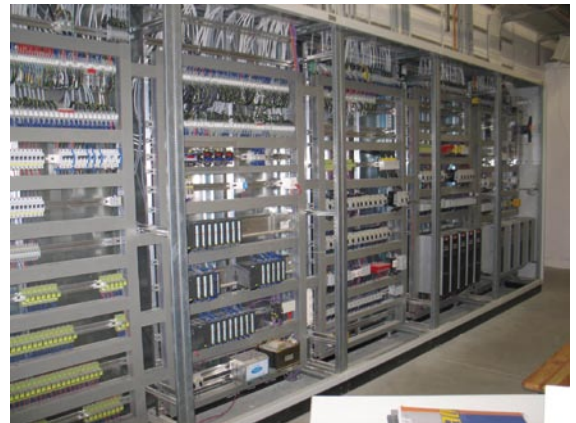
Die Anlage und Prozesse werden mit Hilfe einer frei programmierten SPS-Steuerung überwacht und geregelt.
