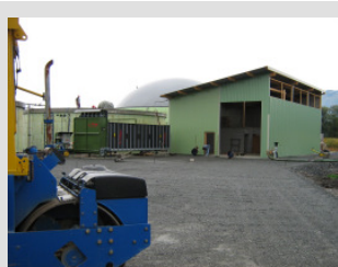
Die Anlage ist mit Hygienisierung, Vorsortierung, Feststoffeintrag, Gasfackel, Lager etc. ausgerüstet
