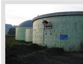
Fermenter und Nachgärer mit über 4'000 m 3 Gärvolumen und 20'000 t/a Verarbeitungskapazität
