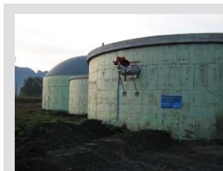
Digesteur et post-digesteur avec un volume de plus que 4000 m 3 et une capacité de substrat de 20'000 t/a
