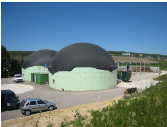
Biogasanlage Roy im Bau: Übersicht der Anlage mit Fermenter und Nachgärer (links), Nachgärer bei Technikgebäude (rechts)
