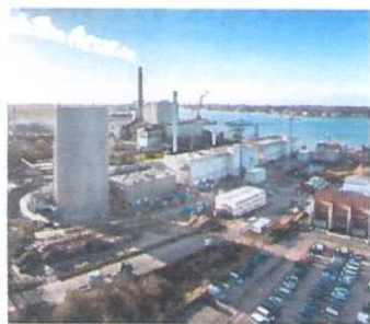
Baufortschritt des neuen Küstenkraftwerks K.I.E.L.
