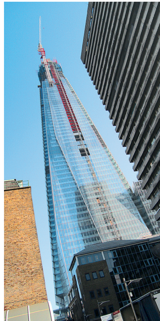
The Shard – Europas höchstes Gebäude wird durch eine WKK-Anlage im 16. Stock mit Strom, Wärme und Kälte sowie Warmwasser versorgt. Foto Peter Odrich
